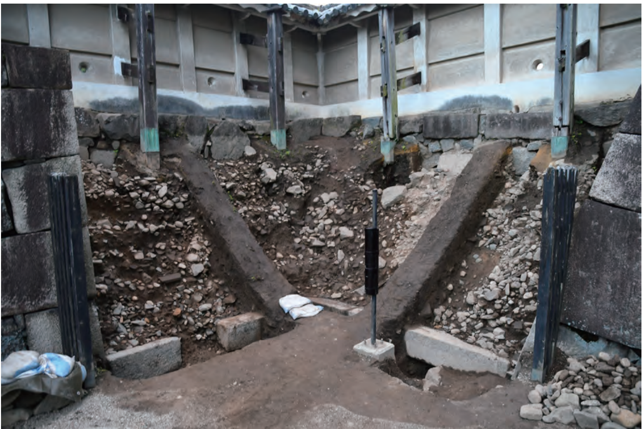
第3次調査 西土塁調査区完掘状況（北東から）
