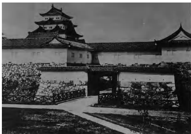
図4-3 ガラス乾板写真「本丸大手口南面」
