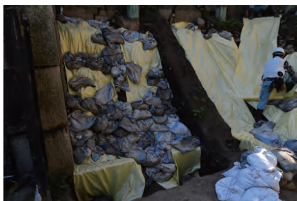
遺構面養生状況（北から）
