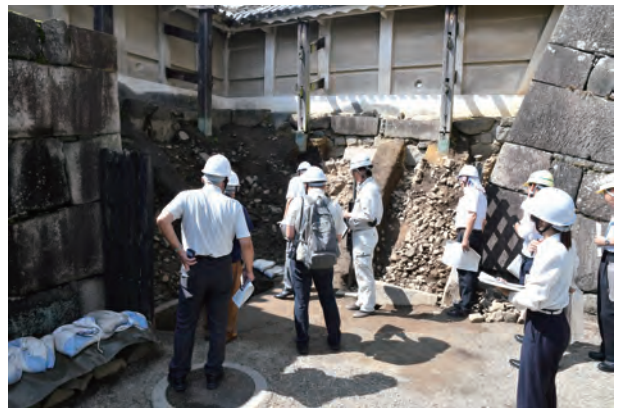
図 1-2 建造物部会 現地視察状況
