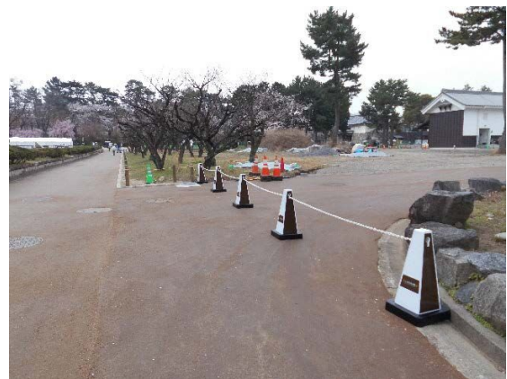
搬出入口付近施工完了風景
