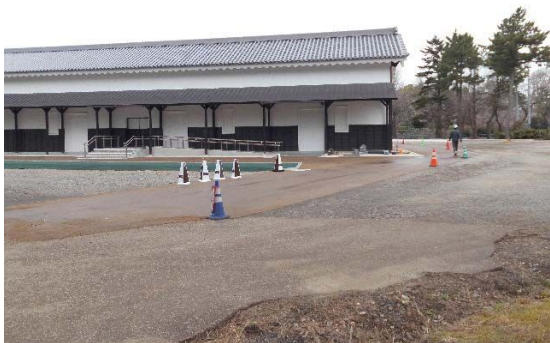
展示収蔵施設付近施工完了風景
