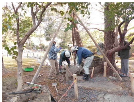
樹木伐採作業
