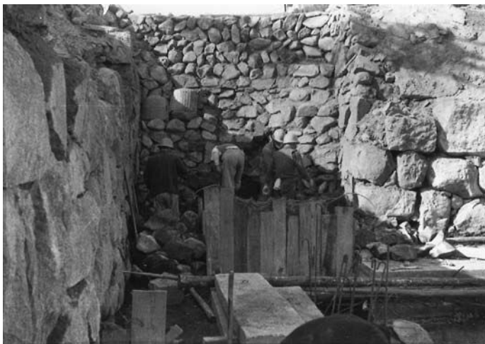
図4 小天守再建中に発見された西側開口箇所写真 名古屋城総合事務所蔵
