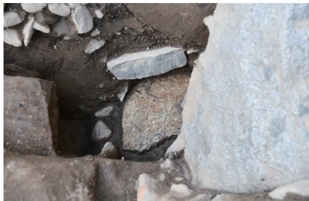
2 Z区大天守台石垣下部刻印石材（南から）
