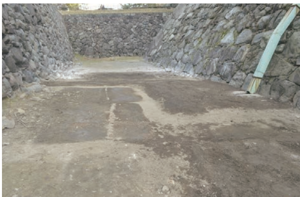
6 R区埋め戻し完了（西から）
