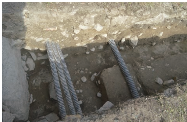
6 T区石垣裾部（南から）
