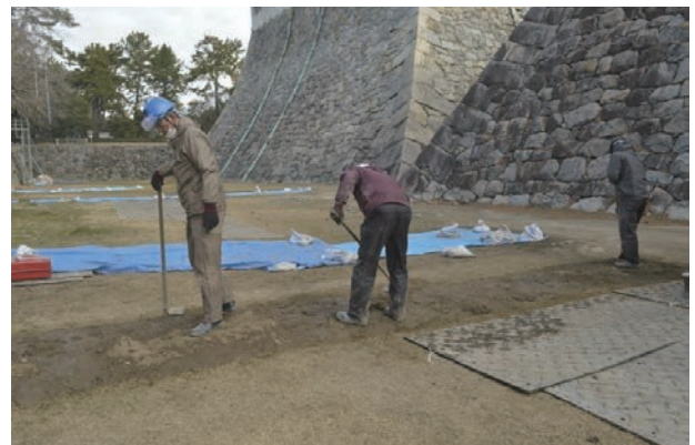
5 V区埋め戻し作業（南から）
