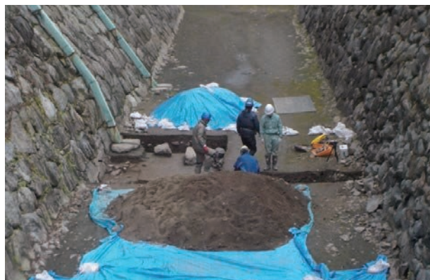
4 R区調査状況（東から）
