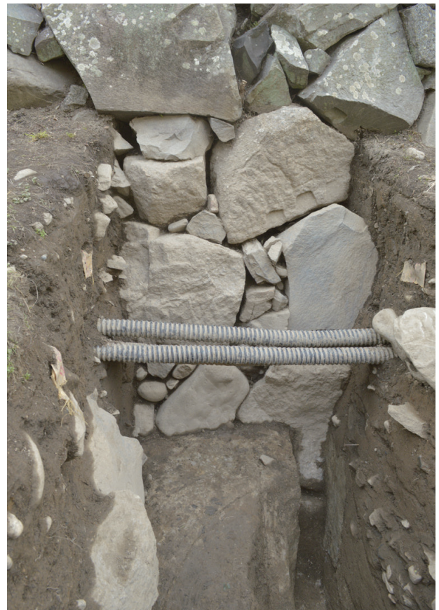
6 石垣裾部状況（東から）
