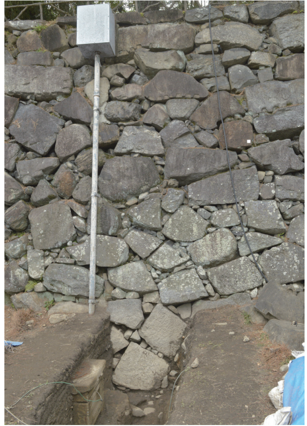
2 S区東側石垣（東から）
