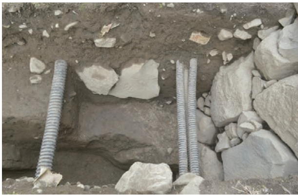
4 石垣裾部状況（北から）
