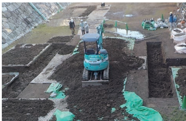
6 埋戻し作業風景（北から）
