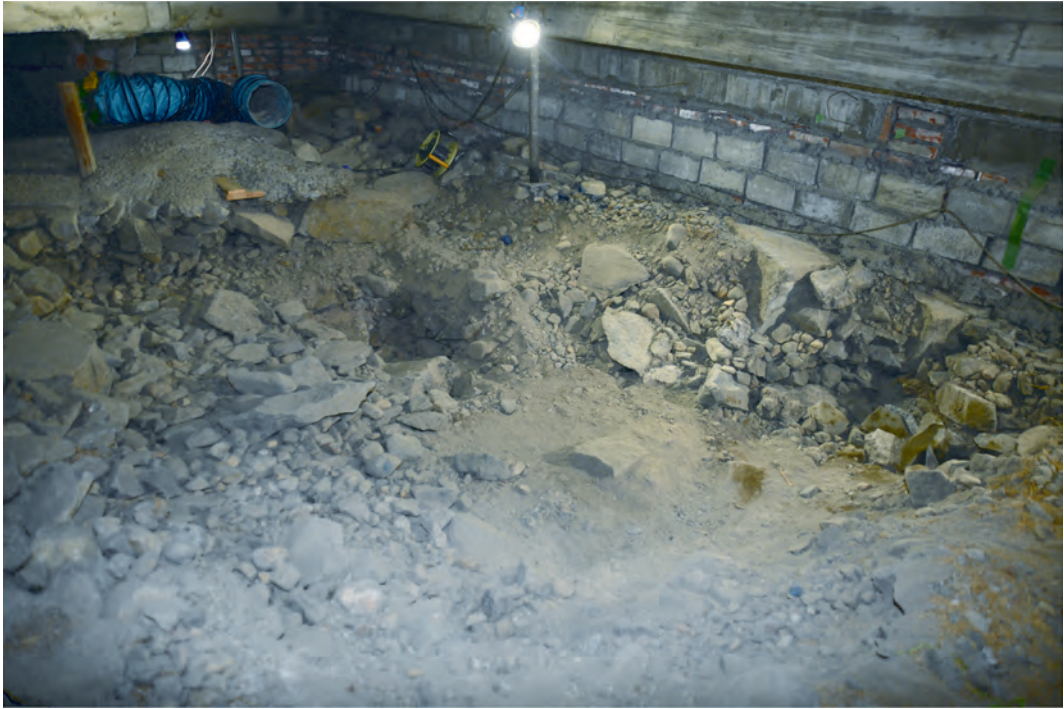
調査区①完掘状況（南から）
