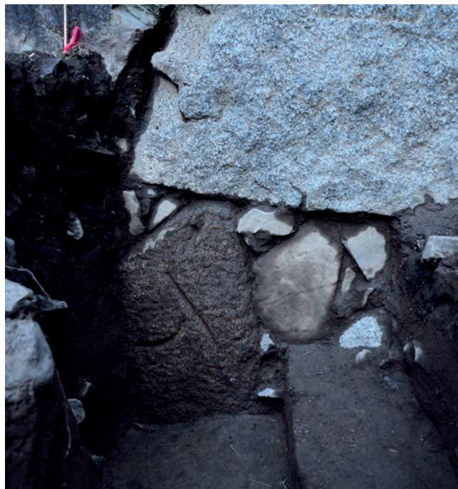
石垣地中部分の状況（西から）
