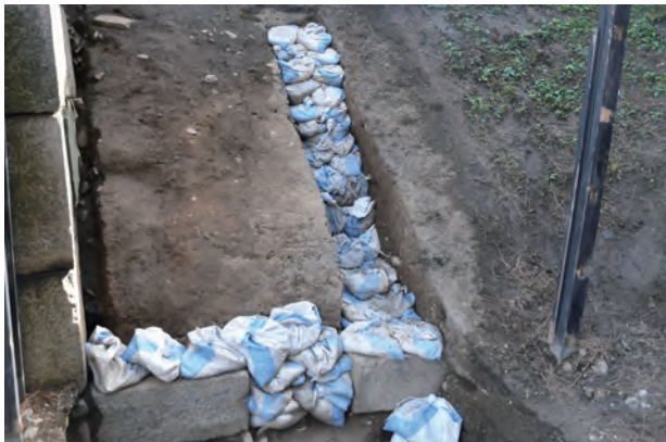
図1-7 遺構面土のう養生状況
