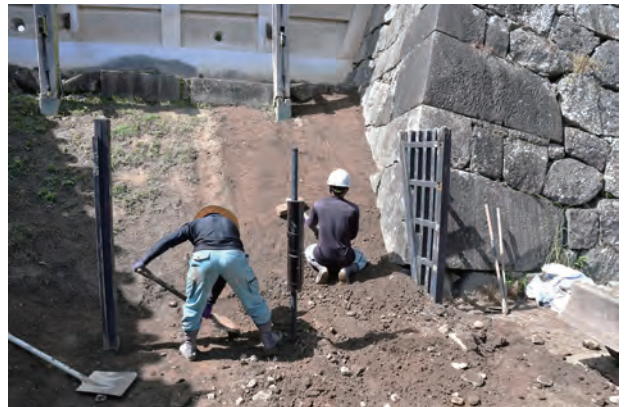
図1-8 埋戻し状況
