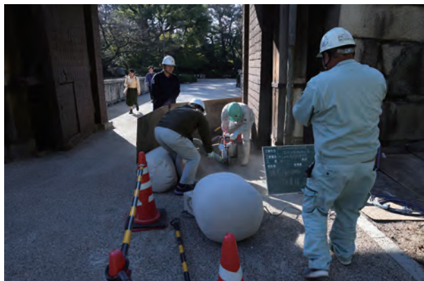
図1-1 アスファルト除去状況
