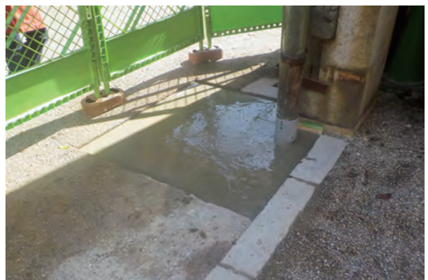
図1-4 アスファルト打設状況
