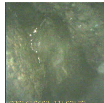
⑨ 深さ 0.4m 円礫が詰まる
