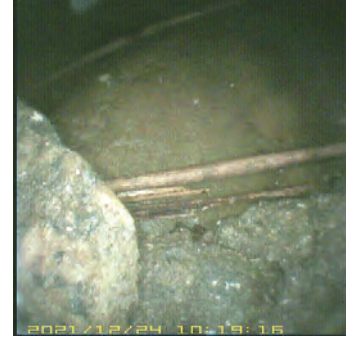
⑨ 深さ 0.35m 円礫が詰まる
