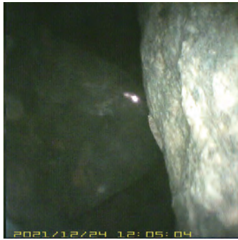
① 深さ 0.35m 円礫が詰まる
