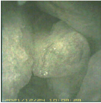
① 深さ 0.3m 円礫が詰まる
