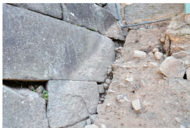
3 調査区3 石垣面検出状況（北西から）
