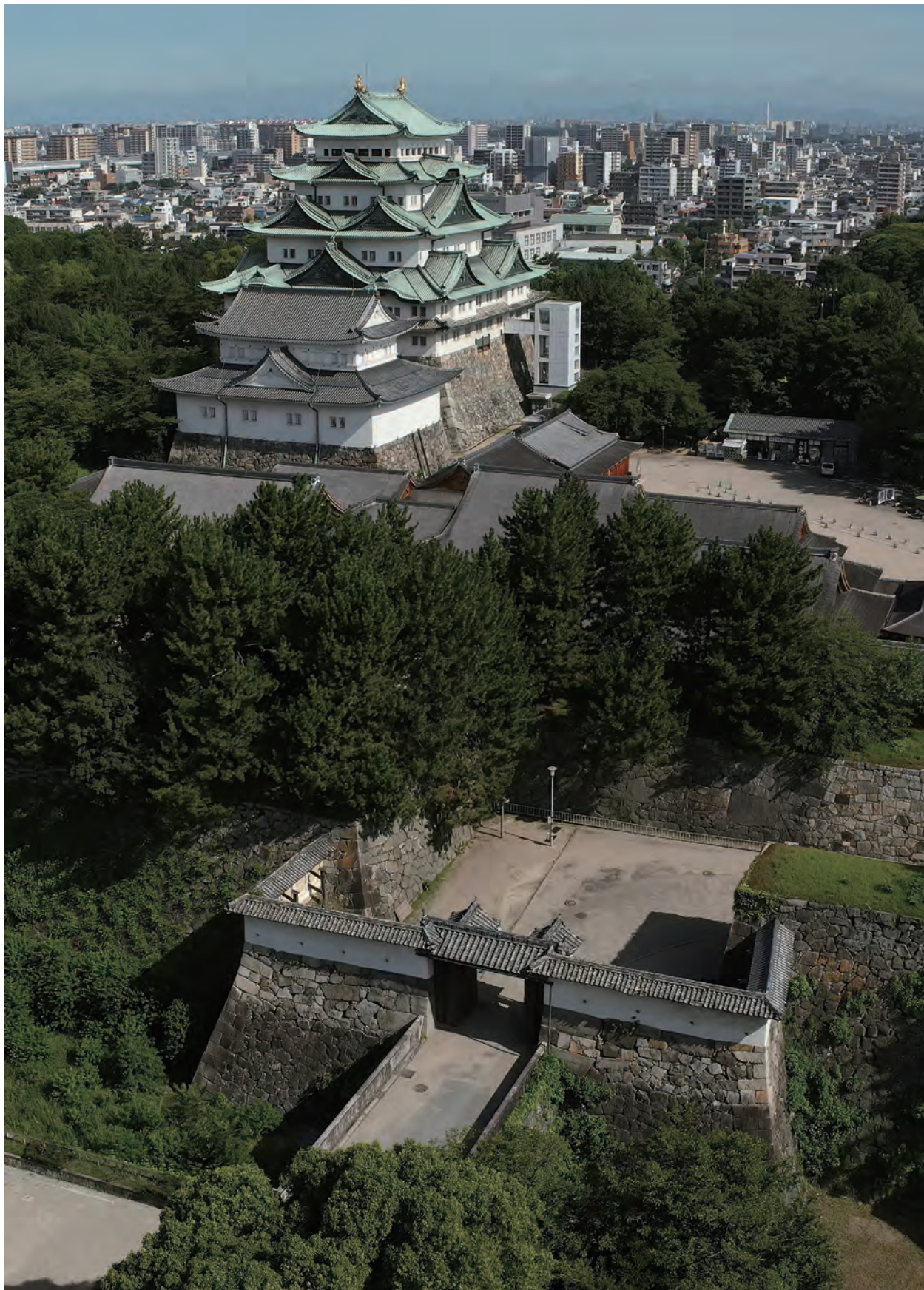
1 重要文化財名古屋城表二の門(手前)と再建天守閣(奥)空撮写真(南から)
