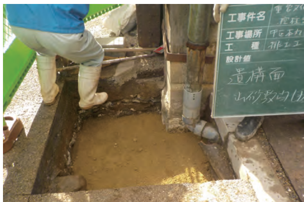
図1-3 埋戻し状況
