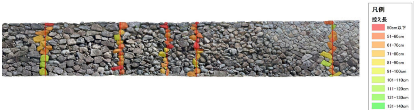
U65 における石垣築石控え長調査結果
