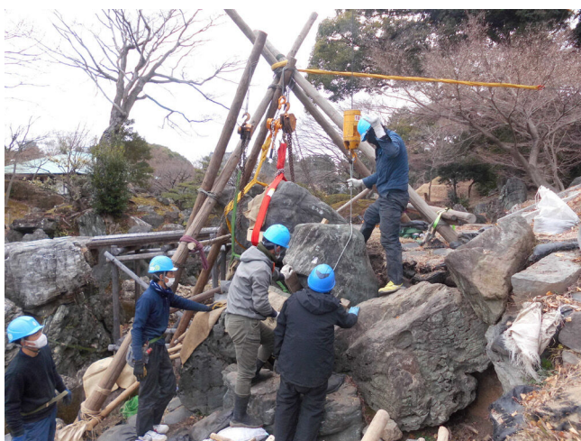
石の据え直し
