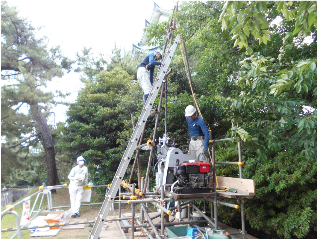
小天守西調査番号⑥における調査風景
